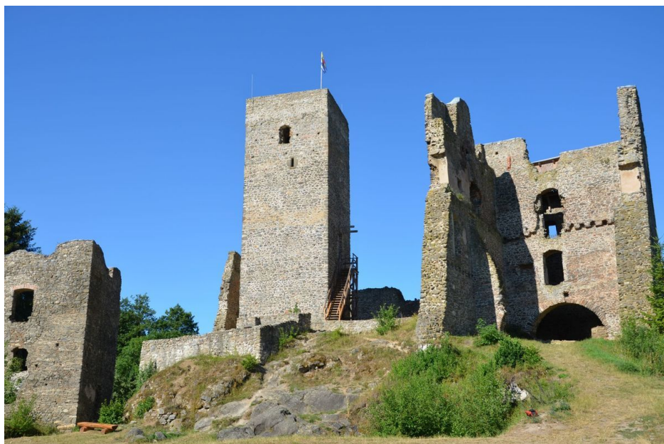
Pohled na hranolovou věž a palác.
