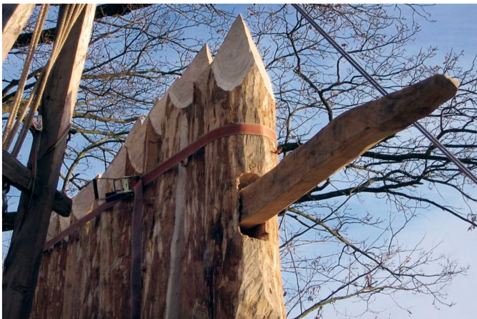
Detail palisády v rekonstruované hradbě.
