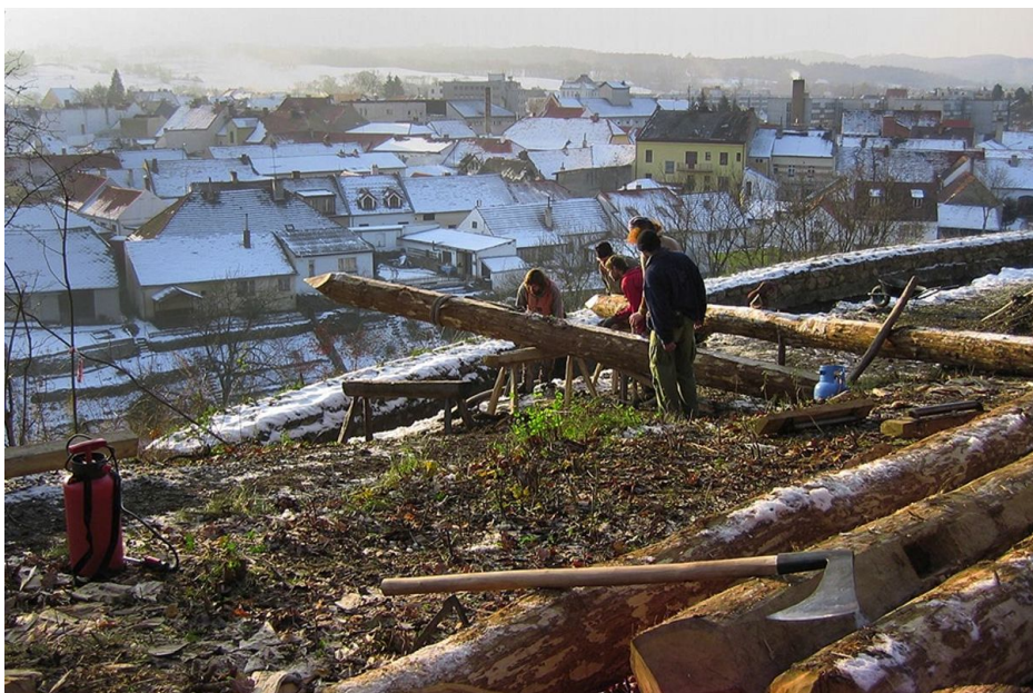
Výstavba rekonstrukce raně středověké hradby.
