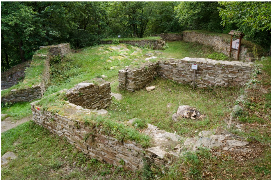
Hradní jádro od severu, v popředí objekt kuchyně, vlevo nároží paláce.
