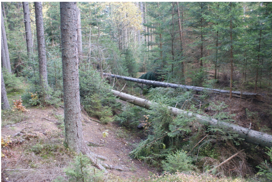
Opevnění poškozené lesním polomem.
