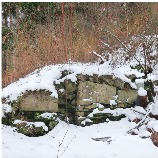
Jižní strana tzv. jižní akropole. Destrukce kamenné plenty s plochými kameny, evokujícími tzv. kyklopské zdivo. Foto S. Langová, 2014.
