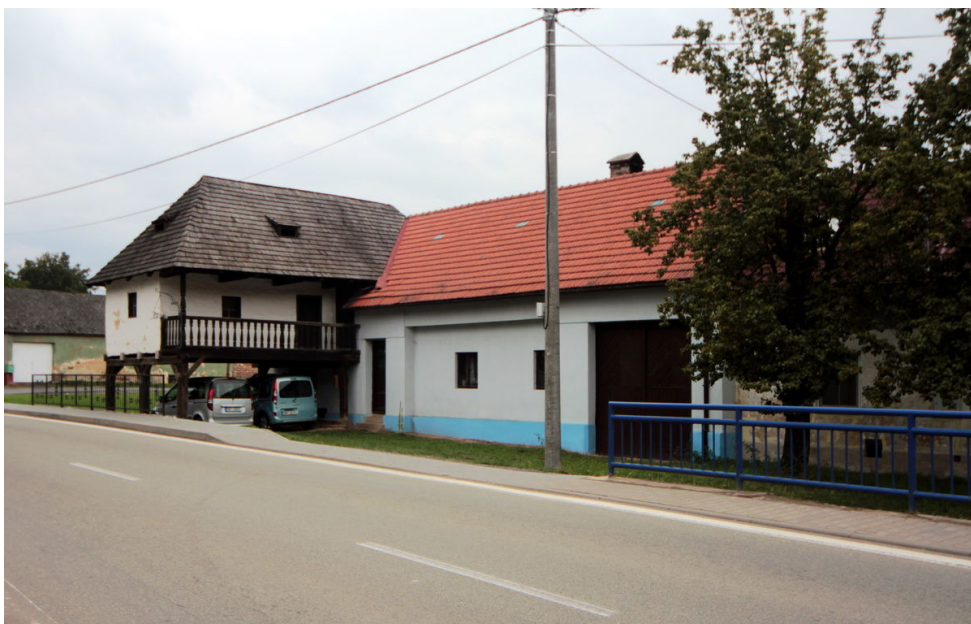
Usedlost čp. 36, pohled od jihovýchodu.
