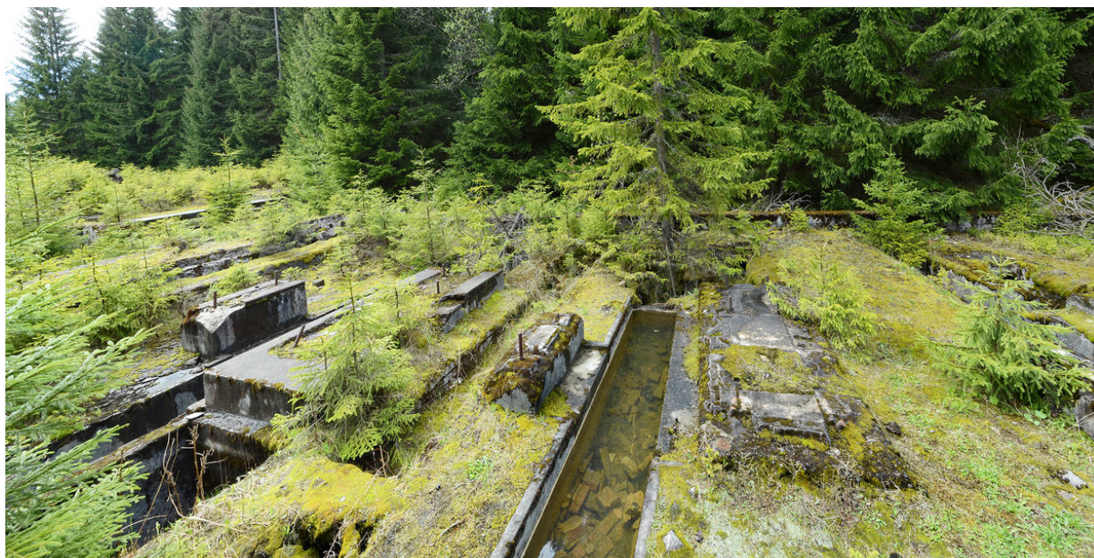
Betonové sokly pro uložení těžebních strojů a důlní ventilace.
