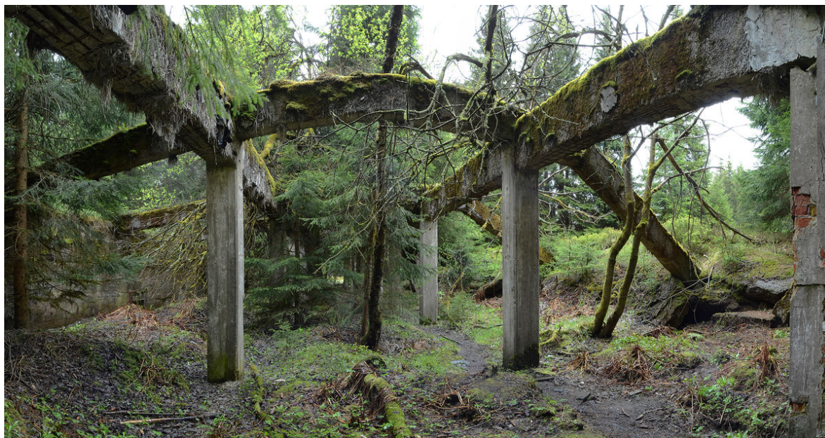
Pohled do skladu zpracované suroviny; na železobetonovém skeletu pozůstatky střešní krytiny a rákosové izolace.
