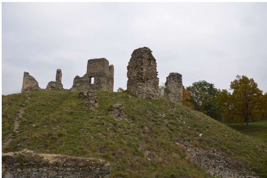
Pohled na jádro hradu od jihozápadu.
