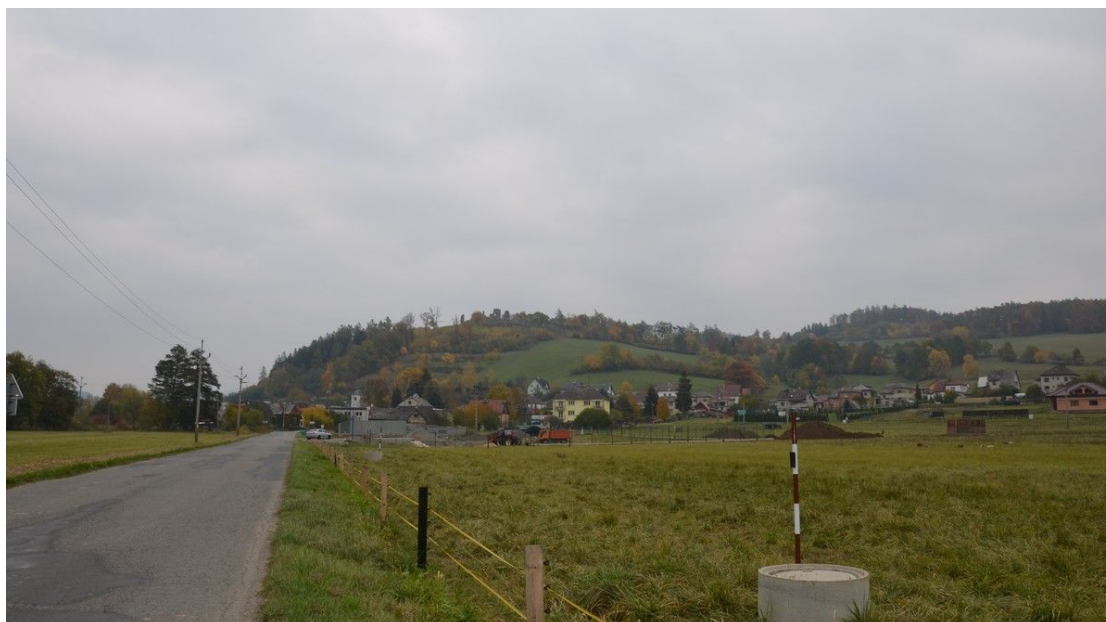
Celkový pohled na hrad od jihozápadu.
